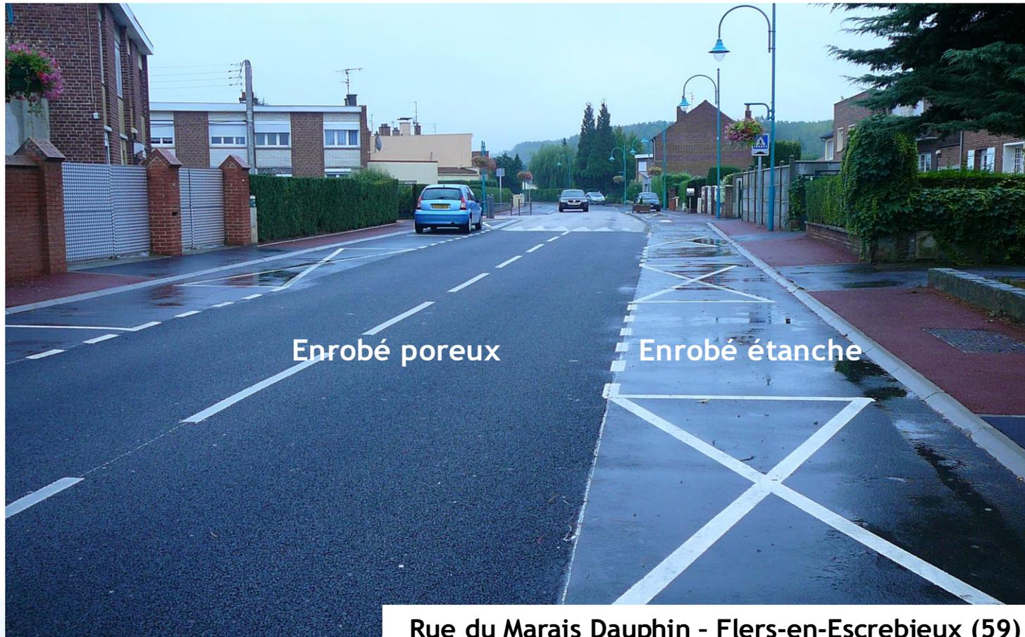
Chaussée à structure réservoir d'infiltration avec poreux et classique
